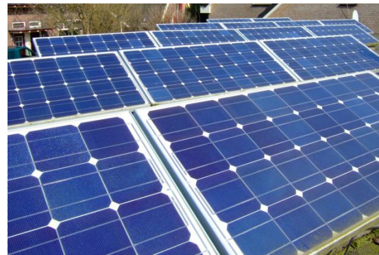
Fig: 2.6.Solar panel
